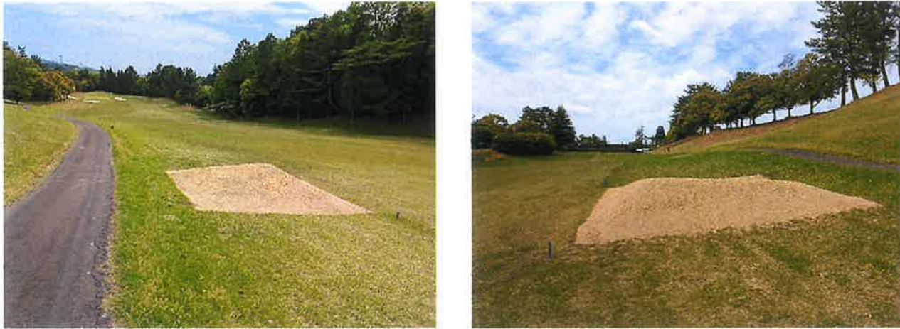
◎1番ホールオレンジティーイングエリアの造成を行っております。
