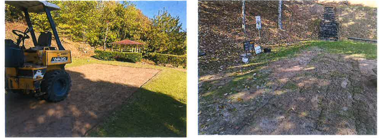
◎12番ホール白・青ティーイングエリア芝張り替え作業を行っております。
